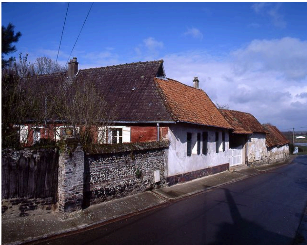
Vue générale depuis le sud.
