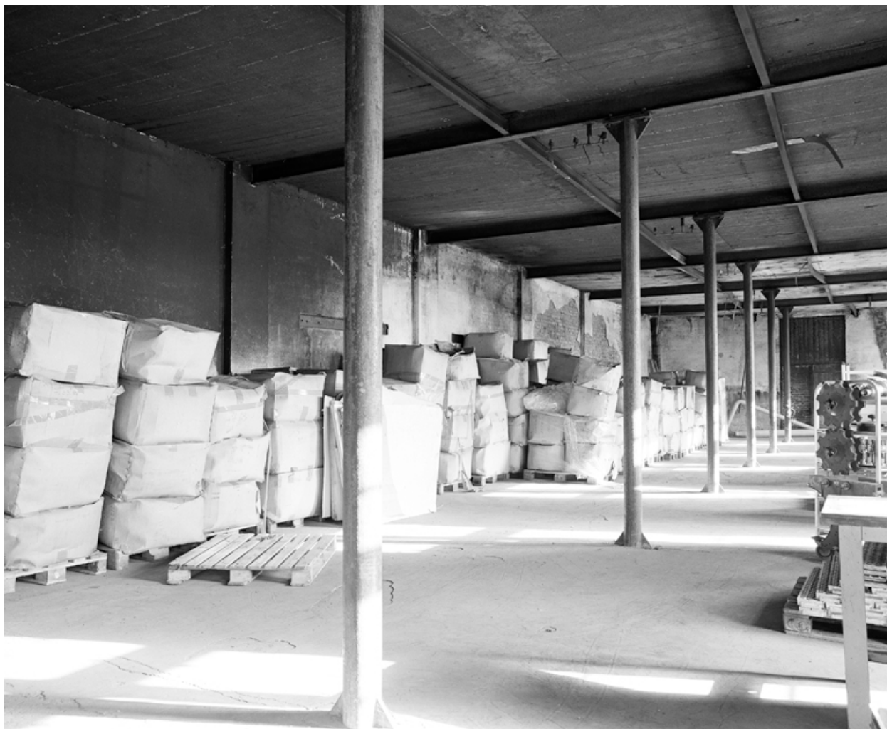
Vue intérieure de l'ancien atelier de fabrication reconstruit vers 1922, au niveau du 1er étage.
