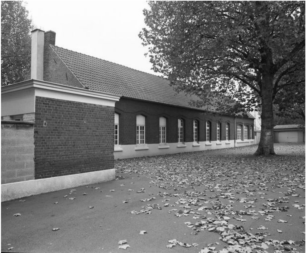
Groupe scolaire, façade sur cour des salles de classe des filles (1873-1875).
