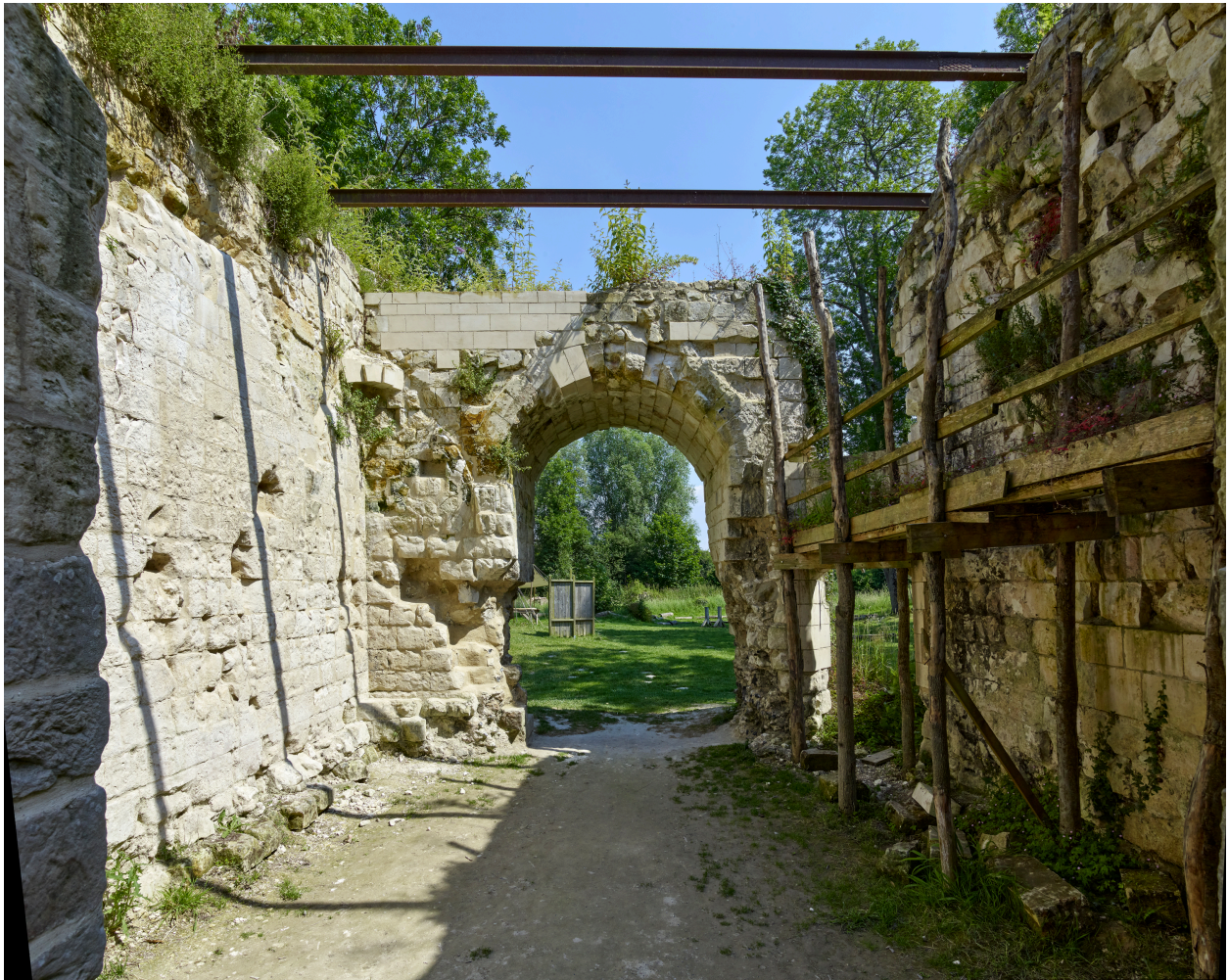
Intérieur du châtelet d'entrée.
