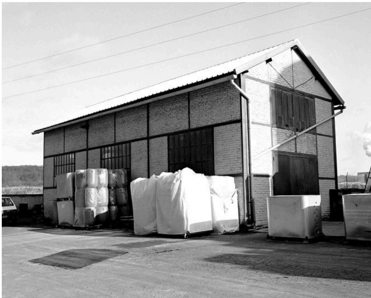
Chaufferie : flanc nord.
