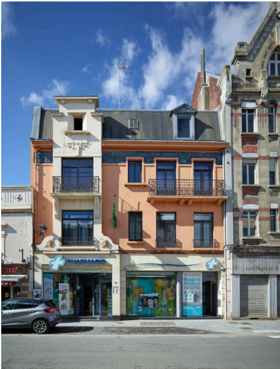
Vue générale depuis la rue de Péronne.
