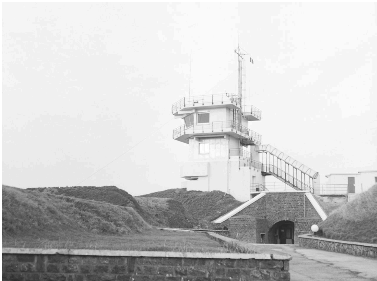
Vue d' ensemble sur cour intérieure.
