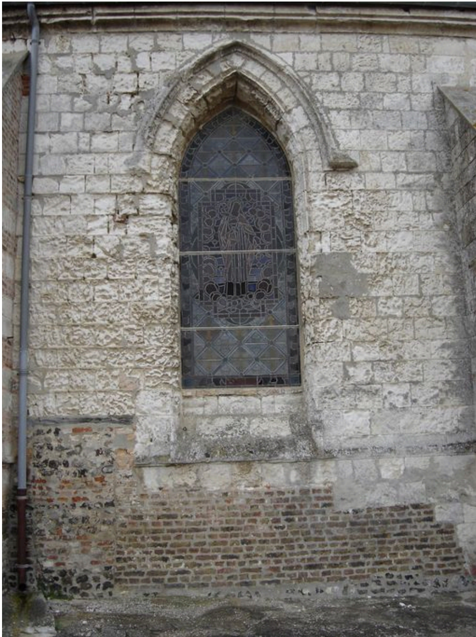
Vue d'une fenêtre à arc brisé du bas-côté nord.
