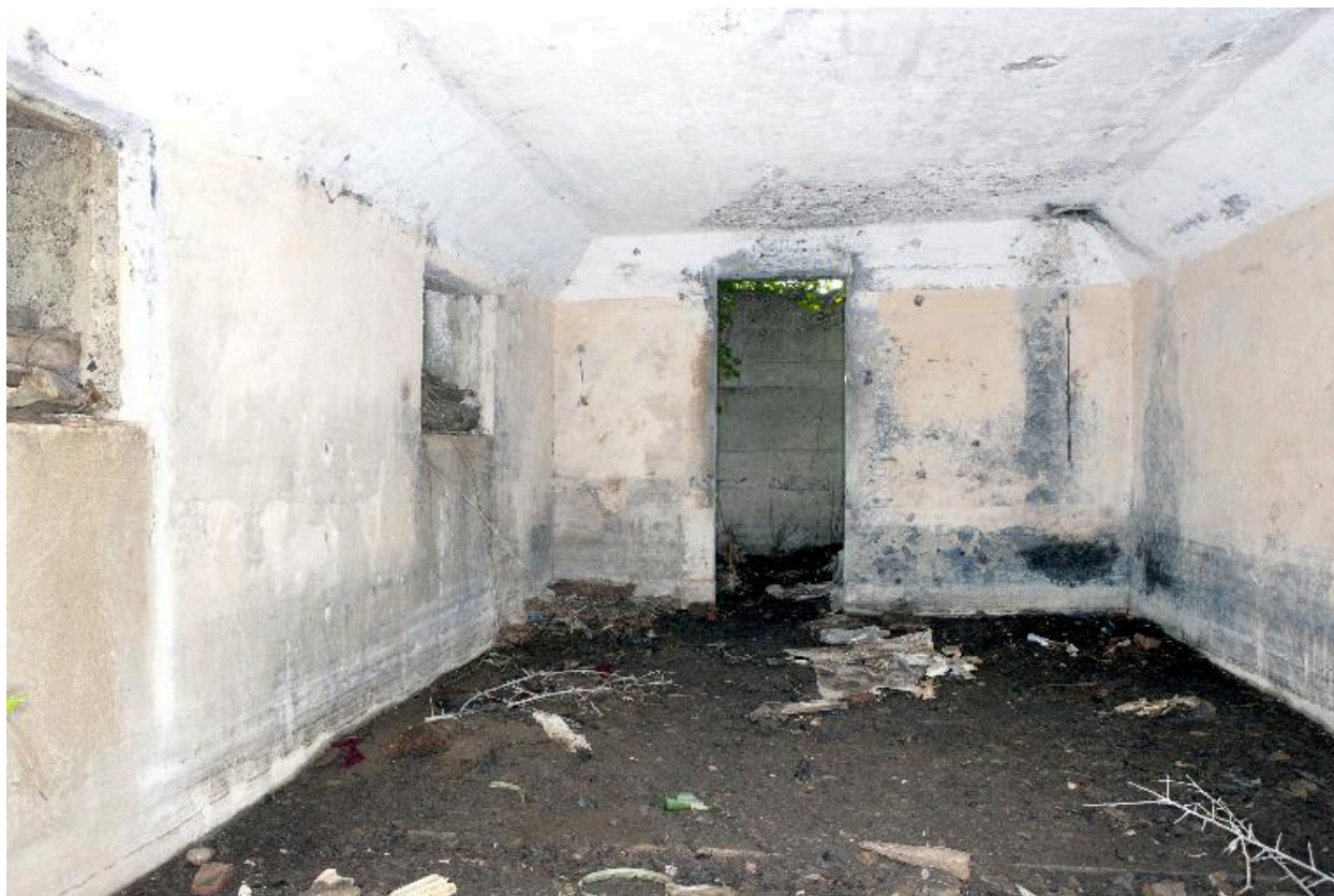
Intérieur de l'édifice depuis l'entrée nord
