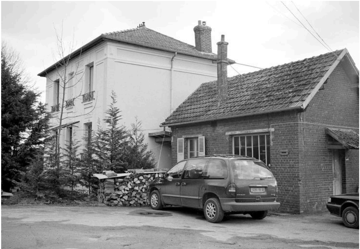
Réception et logement patronal : façade sur cour.
