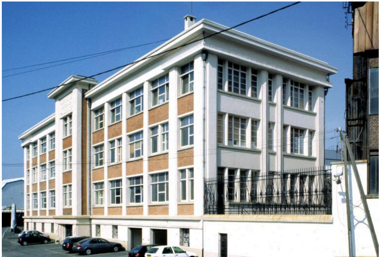
Vue générale des bureaux de la Fabrique de fer de Maubeuge devenue Tata Steel, situés avenue de l'Abbé Jean-de-Beco.
