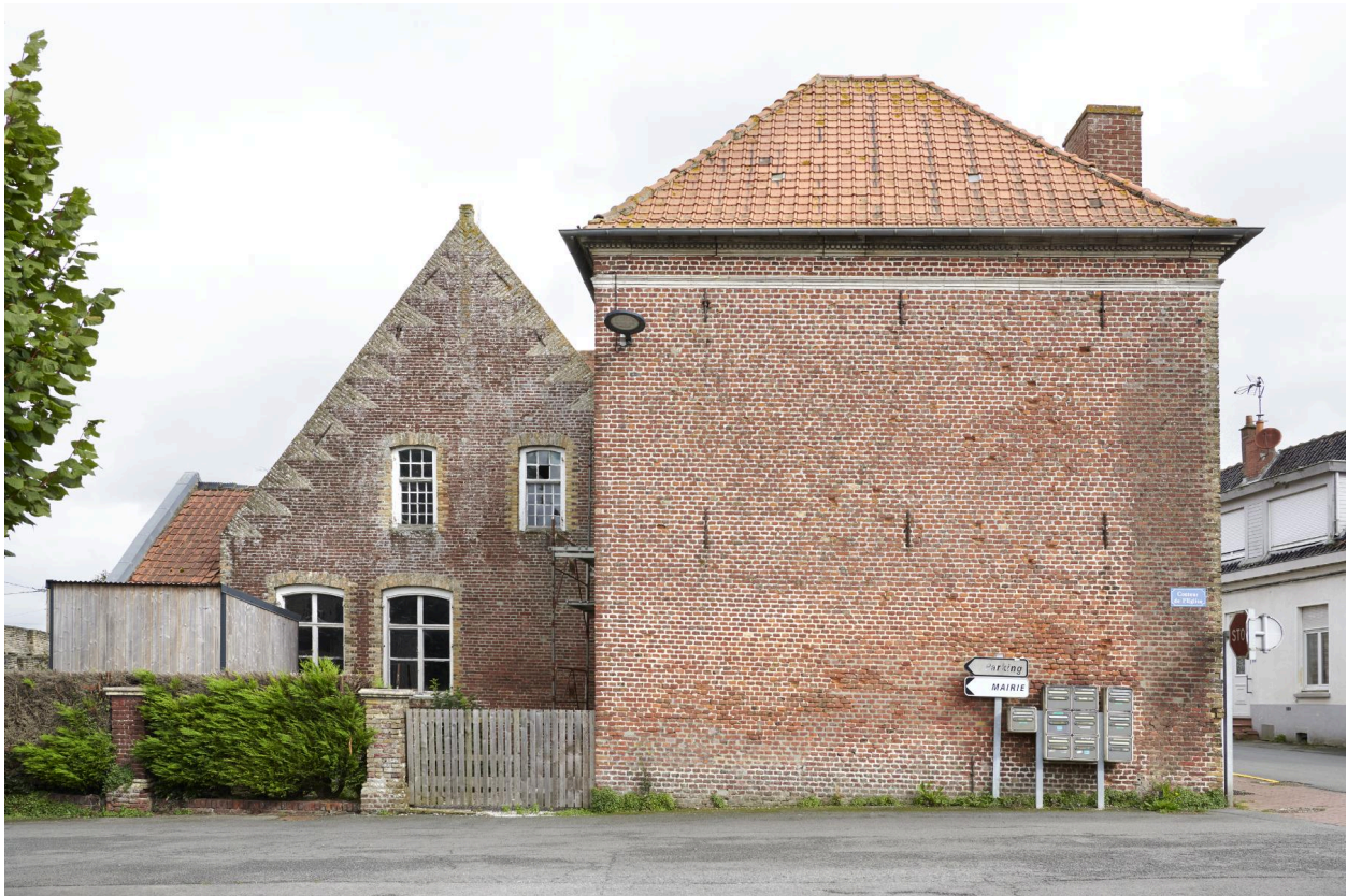
Pignon ouest du logis principal et du pavillon.
