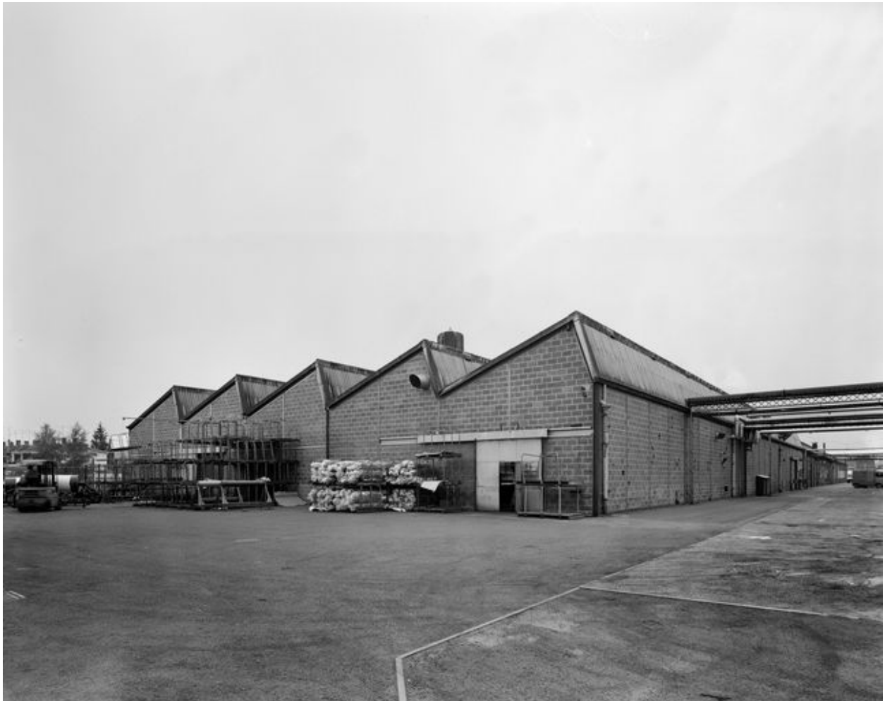
Atelier de fabrication (ancien chemin de la Ville le Marclet), en 1988.
