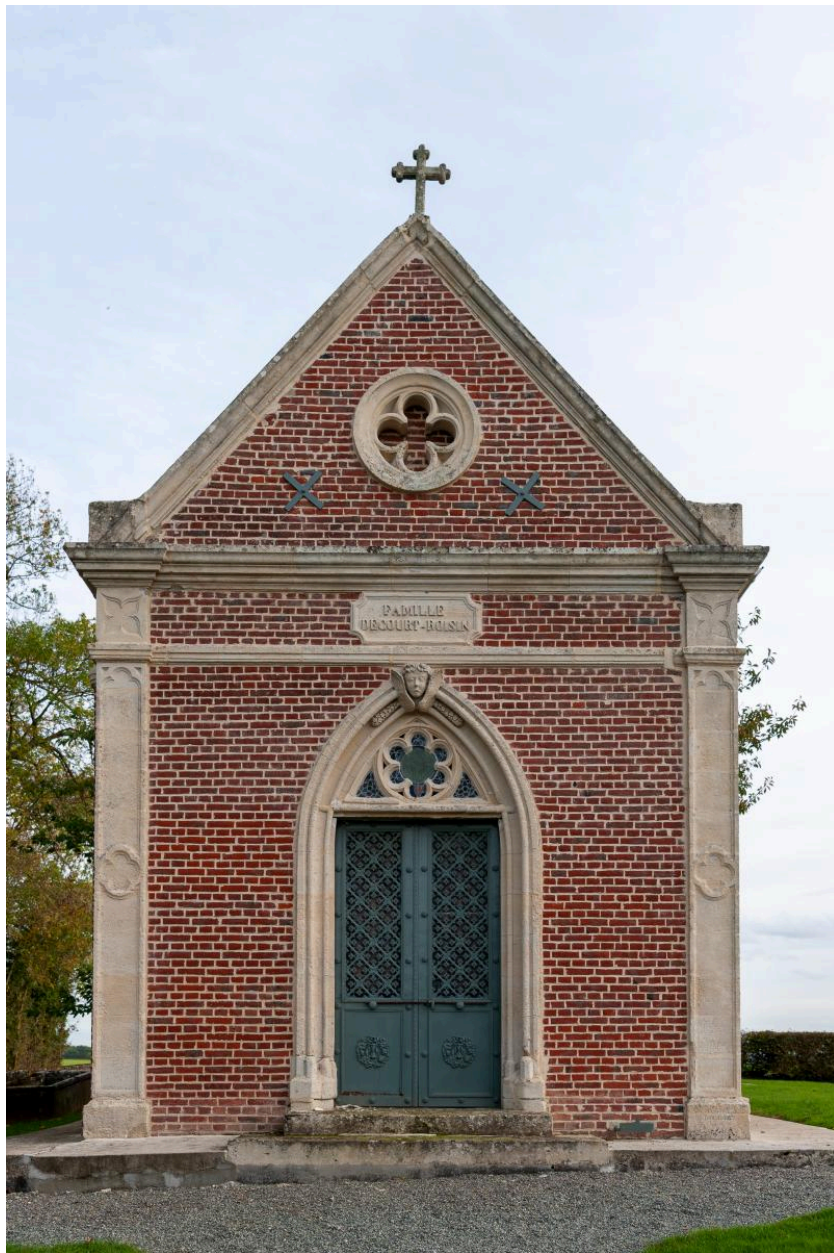
Façade de la chapelle.
