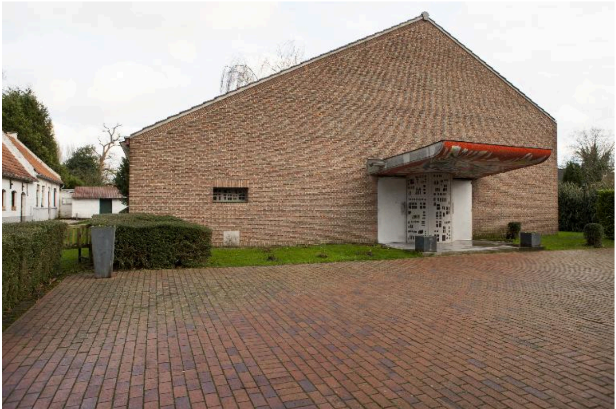
Élévation antérieure de la chapelle.
