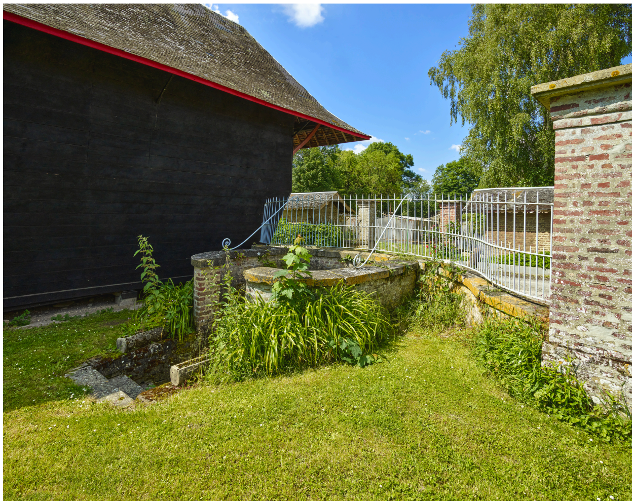
Vue de l'abreuvoir, depuis le sud-est.
