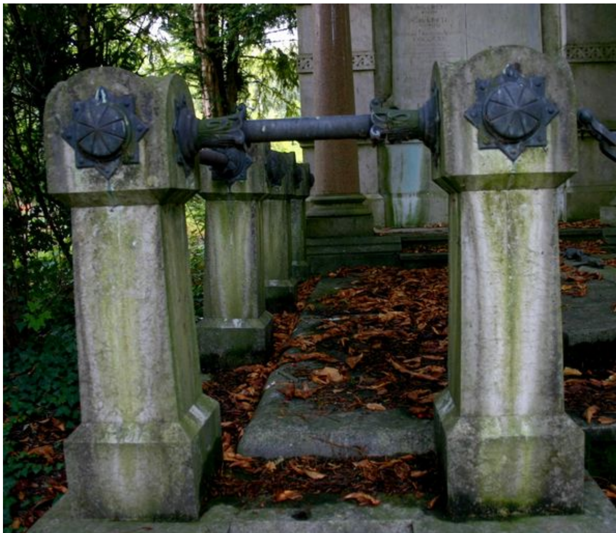
Détail des poteaux de clôture.
