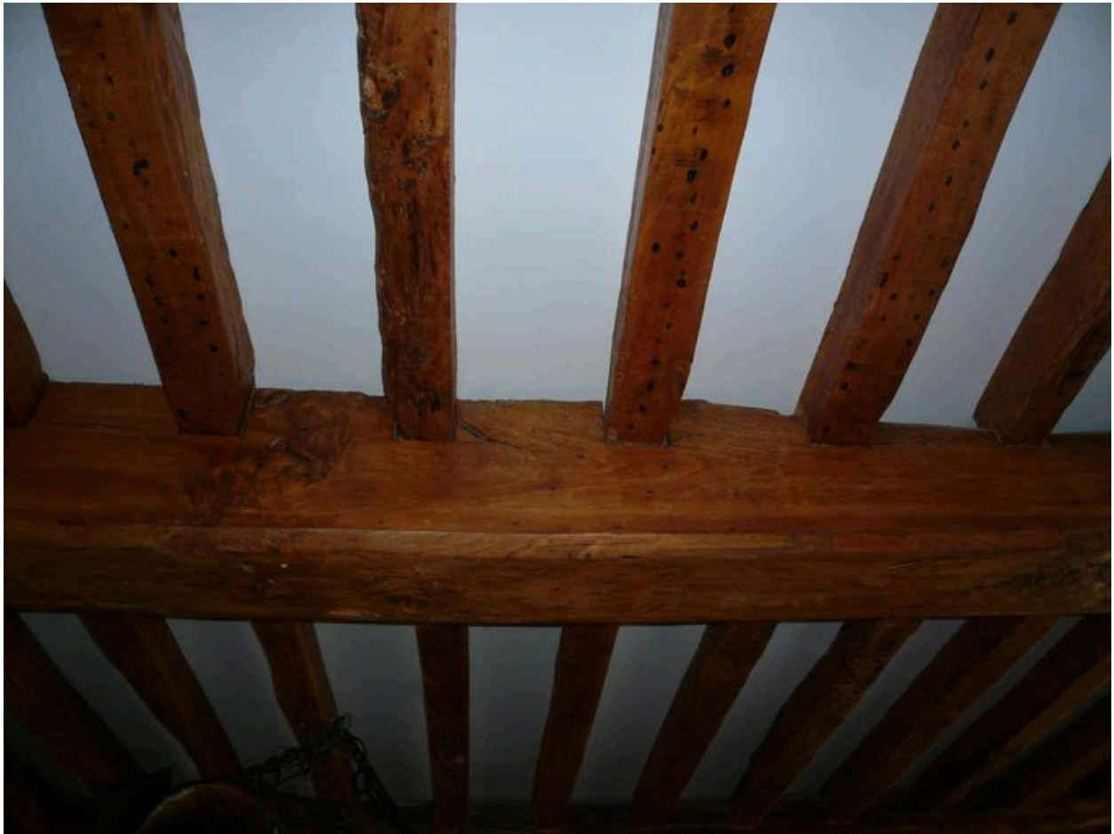
Vue détaillée du plafond de la salle avec poutres et solives apparentes.
