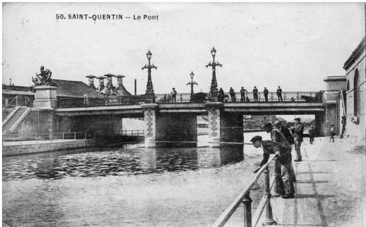
Le pont sur le Canal de Saint-Quentin vers 1900 : à gauche, les toitures de la malterie (BM Saint-Quentin).
