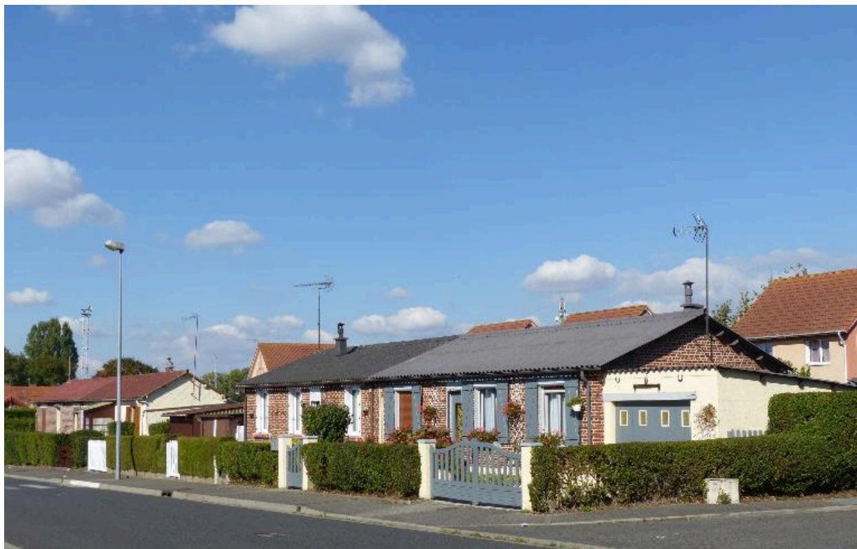
Les maisons reconstruites au milieu du 20e siècle, rue Paul-Baroux.
