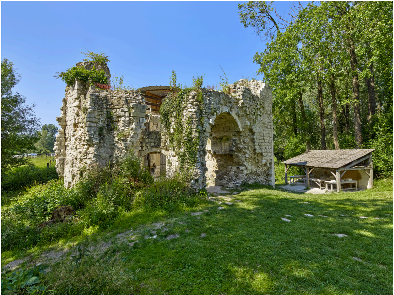
Vue du châtelet d'entrée depuis le sud.
