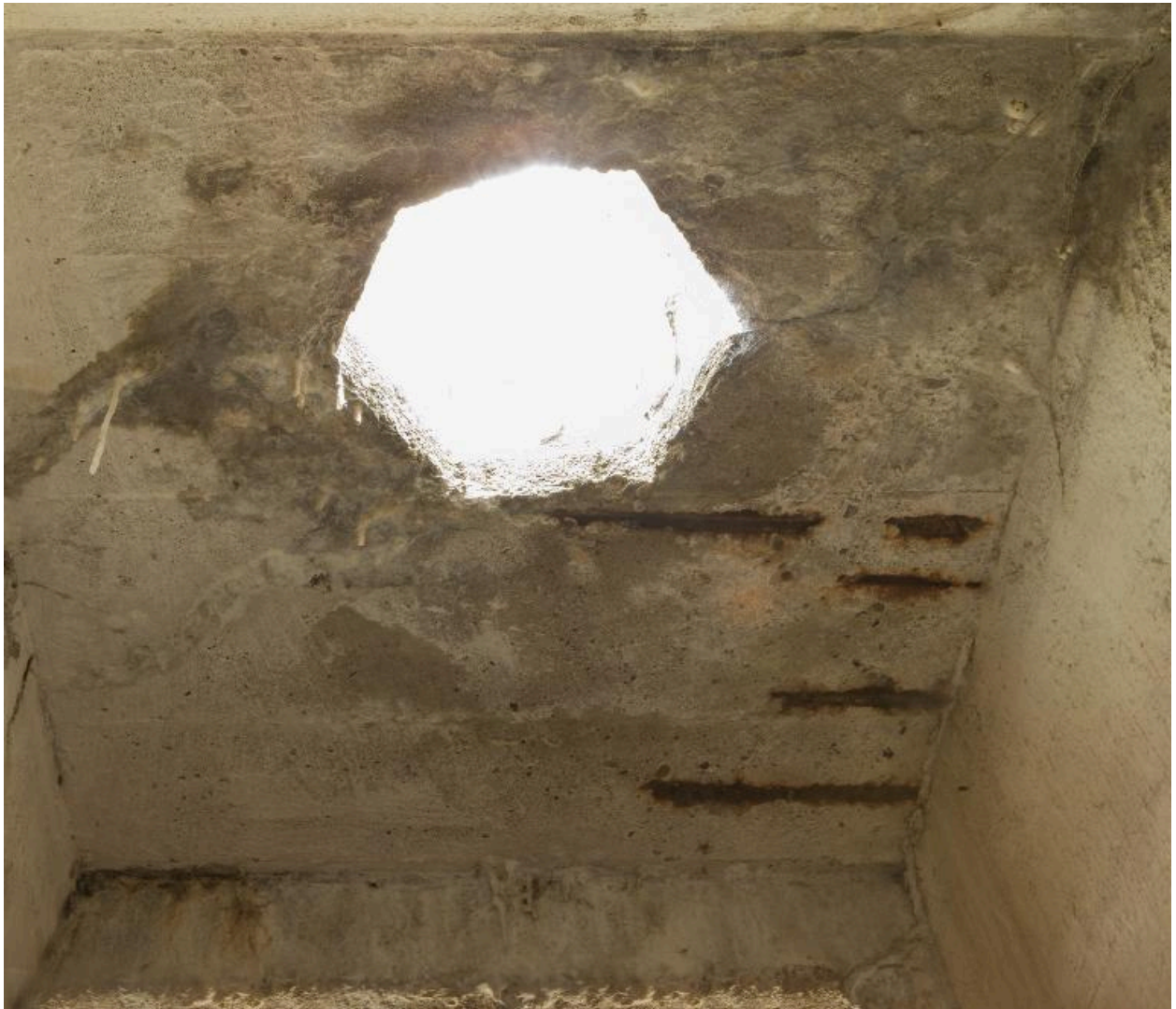
Casemate b. Vue intérieure de l'observatoire bétonné. Passage du périscope.
