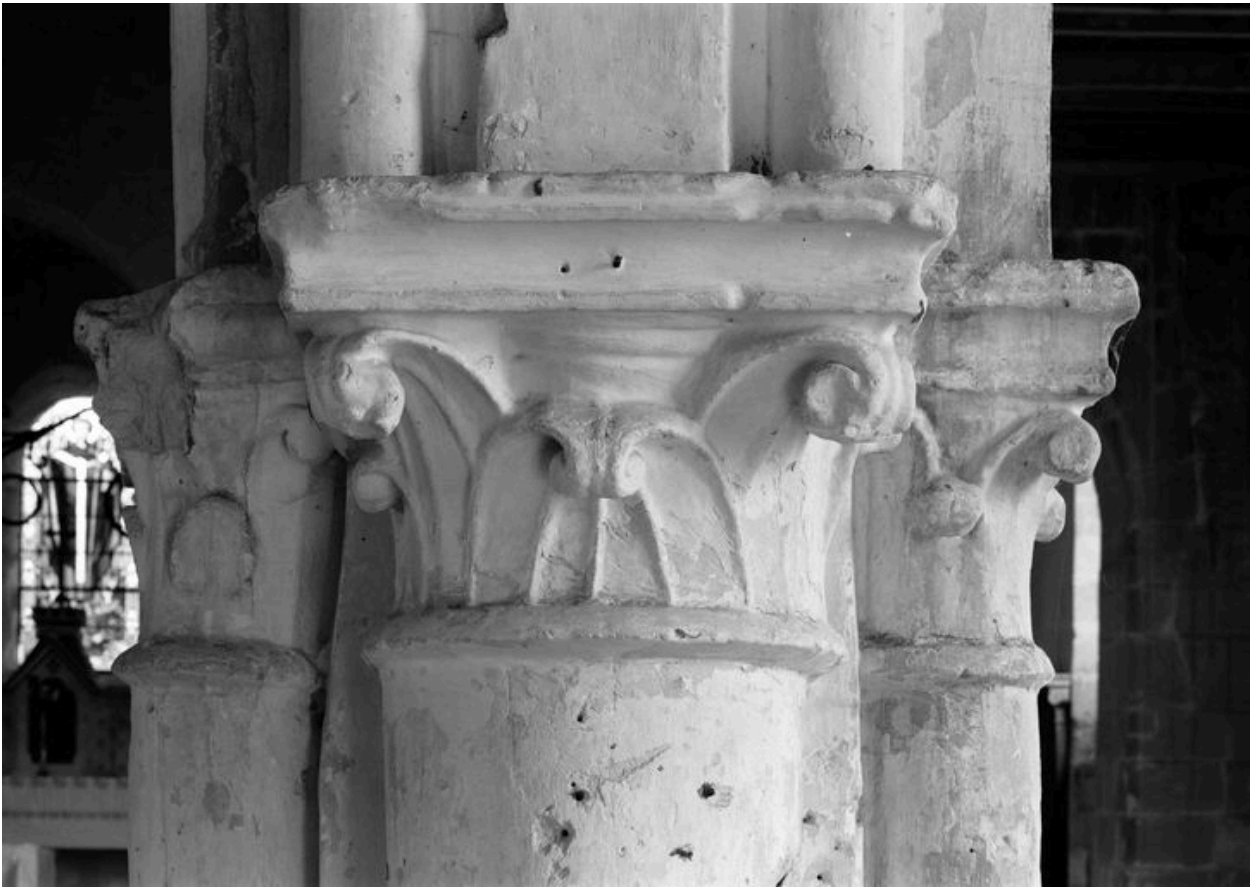
Bas-côté sud : détail d'un chapiteau.
