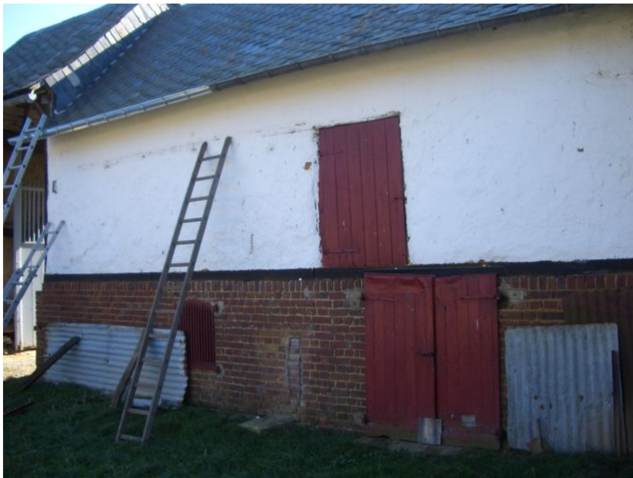
Vue de la grange est avec cave semi-enterrée.
