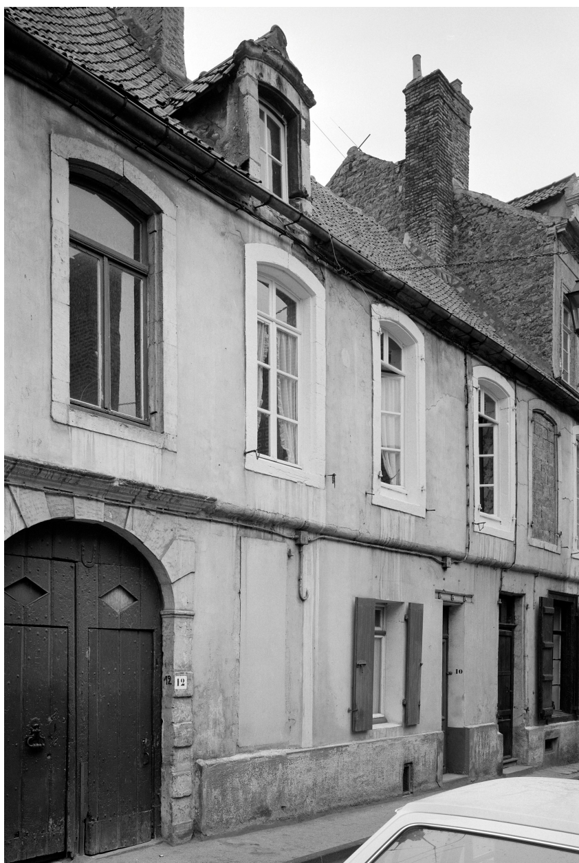
Façade partielle sur voie avant restauration.
