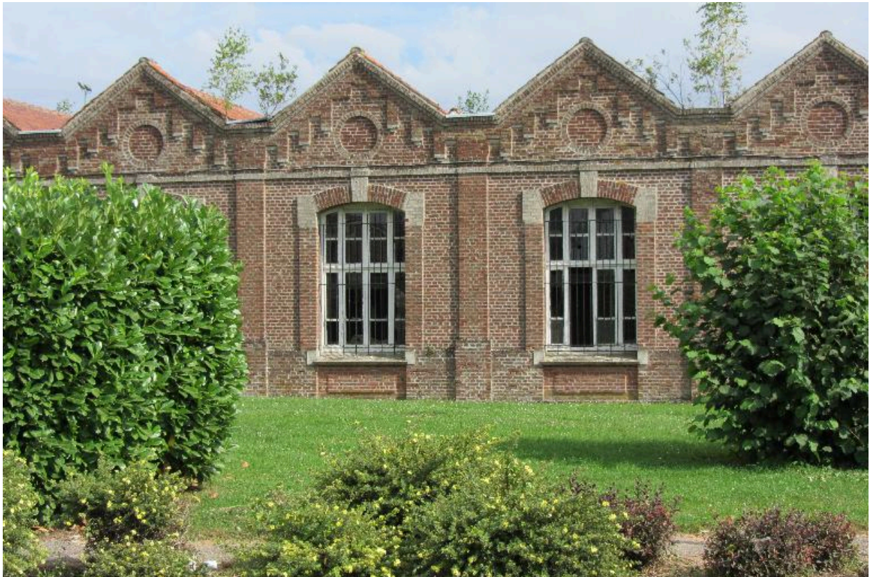
Façade sur rue des bâtiments administratifs, vue partielle.
