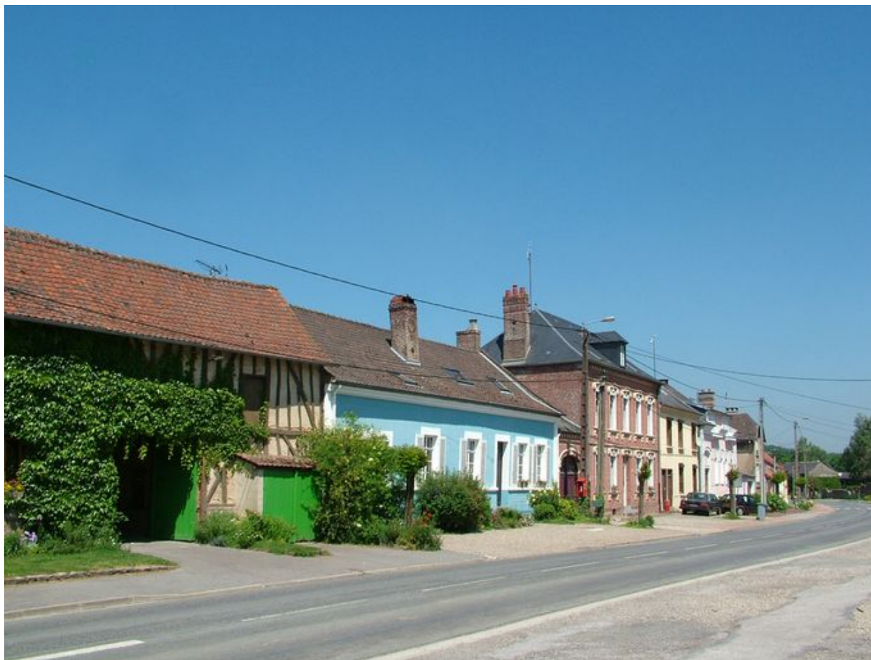
Alignement des maisons 195, 185, 177 et 163, rue de Fieffes.
