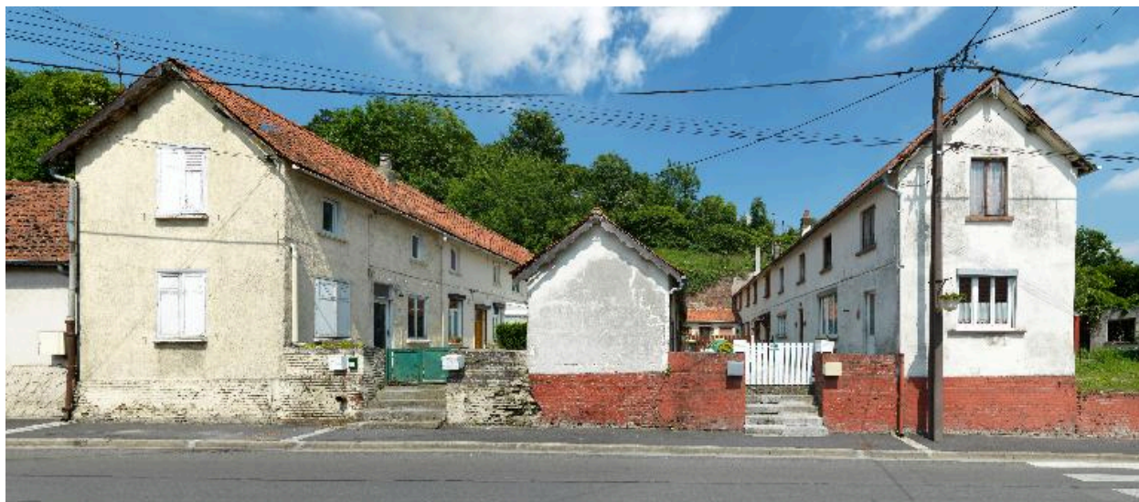
Vue d'ensemble sur rue de la cité ouvrière.
