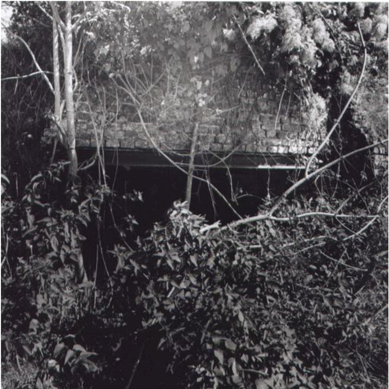
Entrée de la galerie d'extraction de la chaux, creusée dans la carrière voisine.
