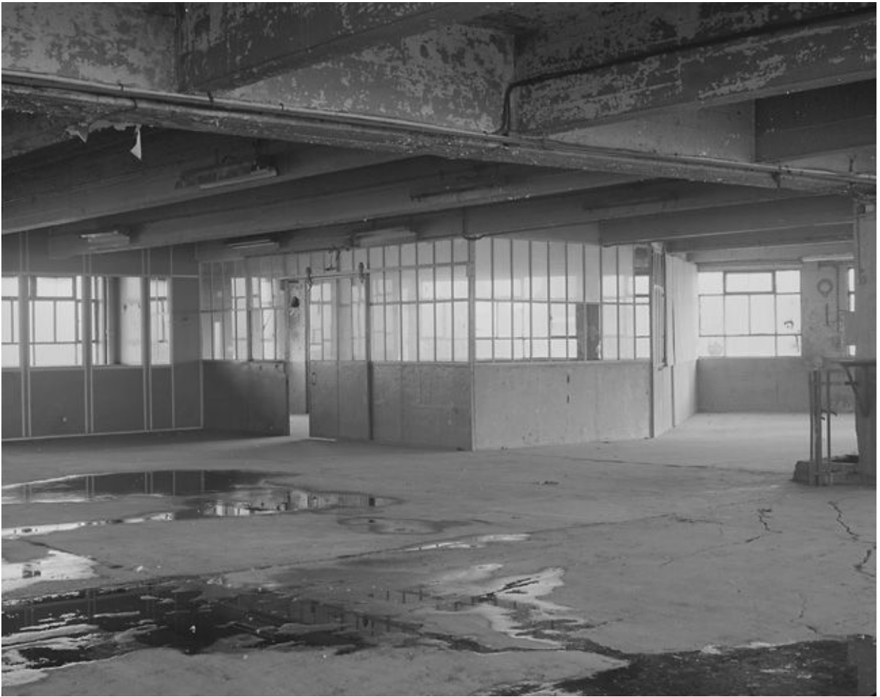
Vue d'une partie des bureaux au niveau 3.
