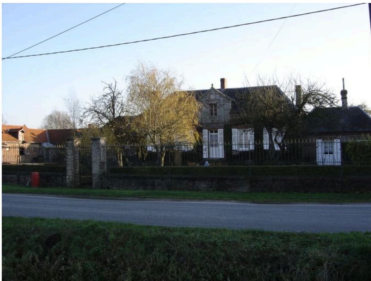
Vue d'ensemble de la façade du logis.
