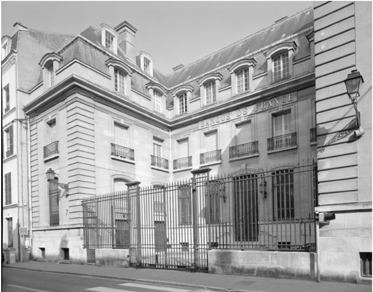
Elévation sur la rue Carnot.
