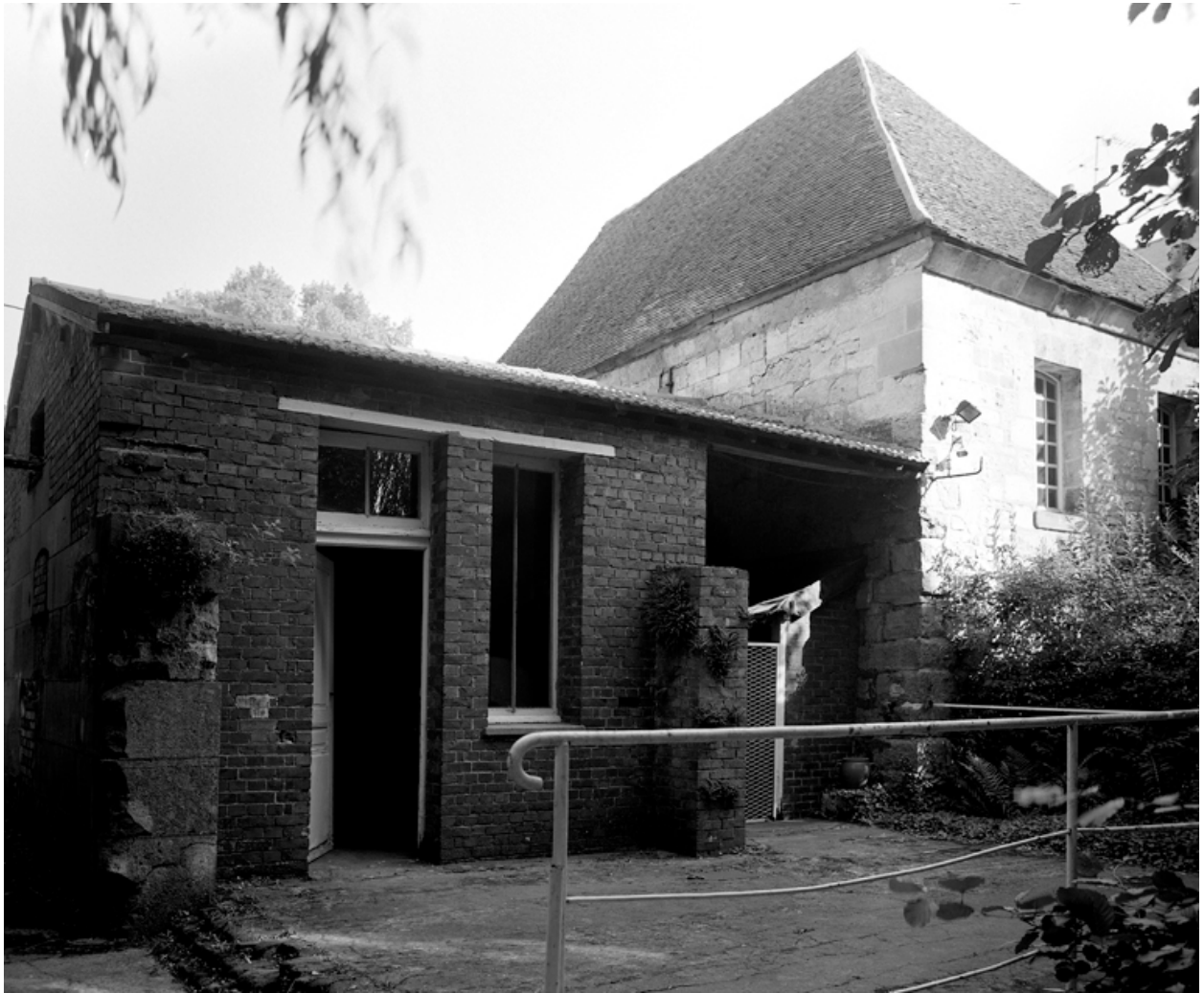
Façade sud de la salle des machines et de l'atelier de fabrication en pierre de taille.
