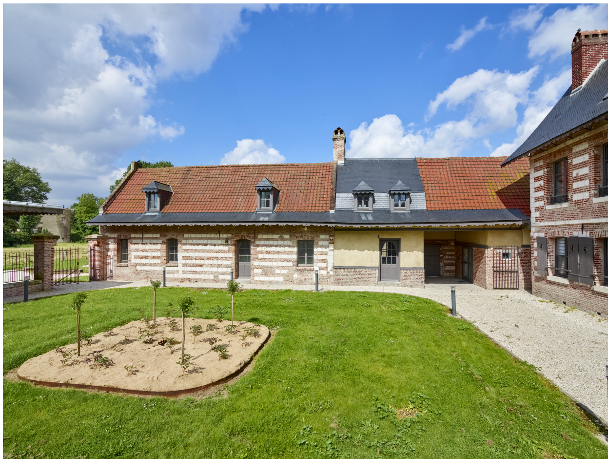
Bâtiment ouest de la ferme, depuis la cour.
