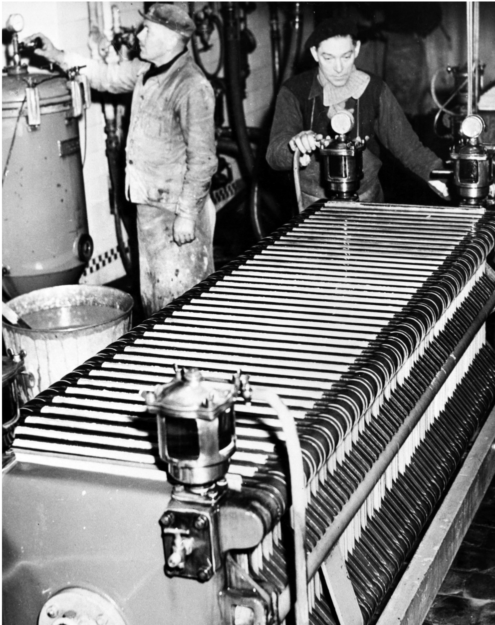
Filtre Kieselguhr (ou à terre diatomée) : filtration finale avant conditionnement, 1954 (AP Coutances).
