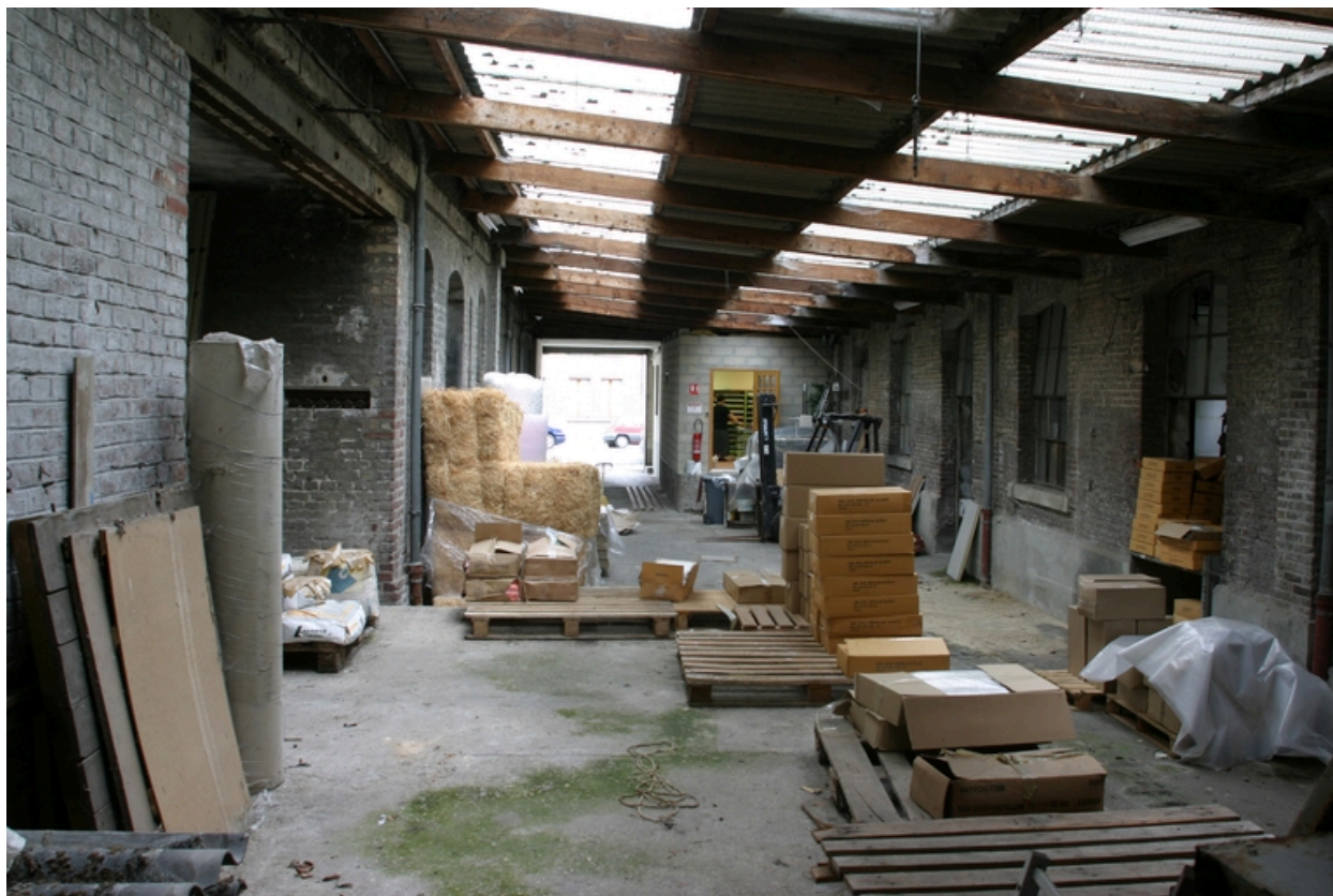
Vue de la cour couverte, depuis le fond de la cour.
