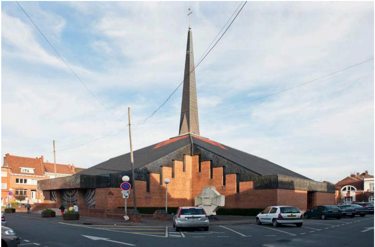
Élévation antérieure et flanc droit.
