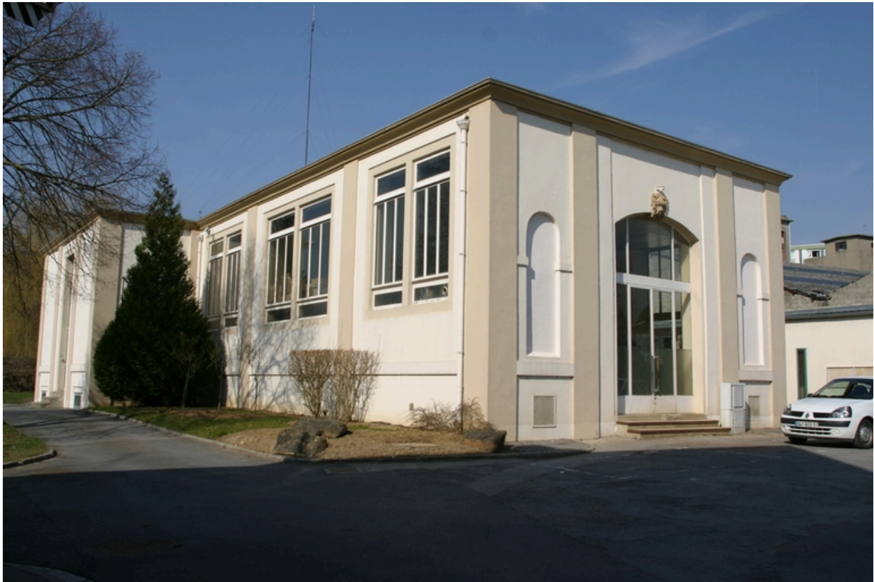
Anciennes salle des machines et chaufferie.
