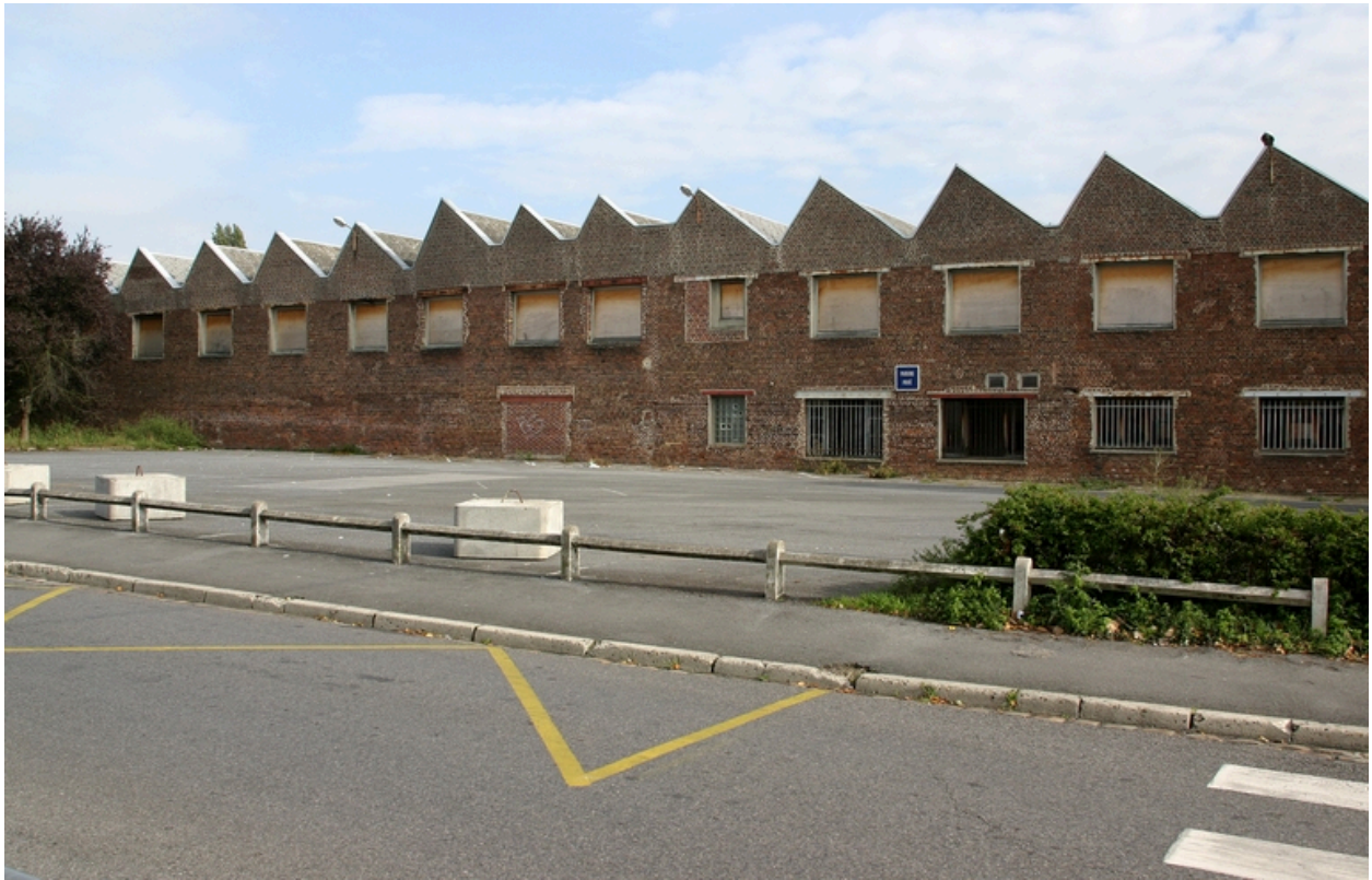
Ateliers antérieurs à 1900 (ensemble ouest) : façade occidentale.
