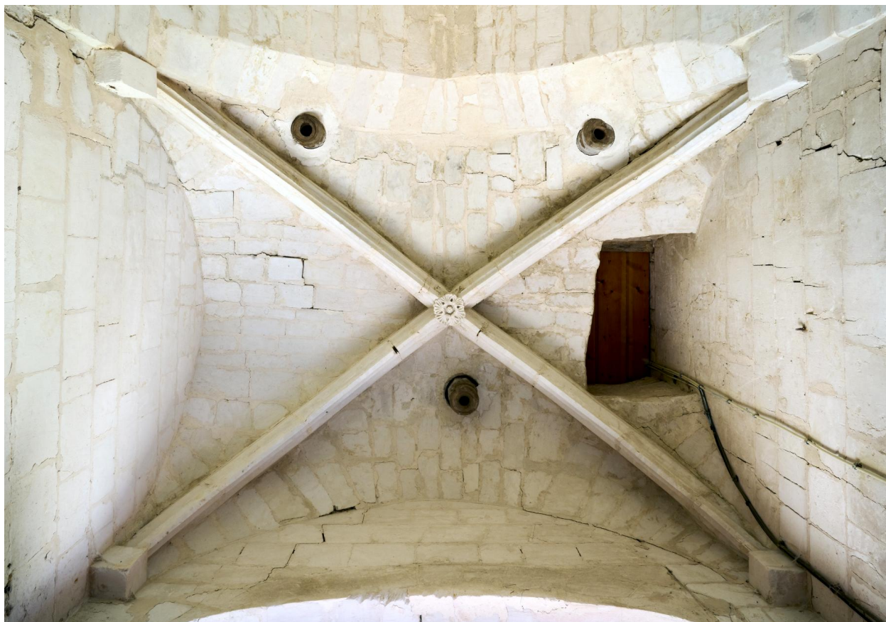
Intérieur, voûte du clocher.
