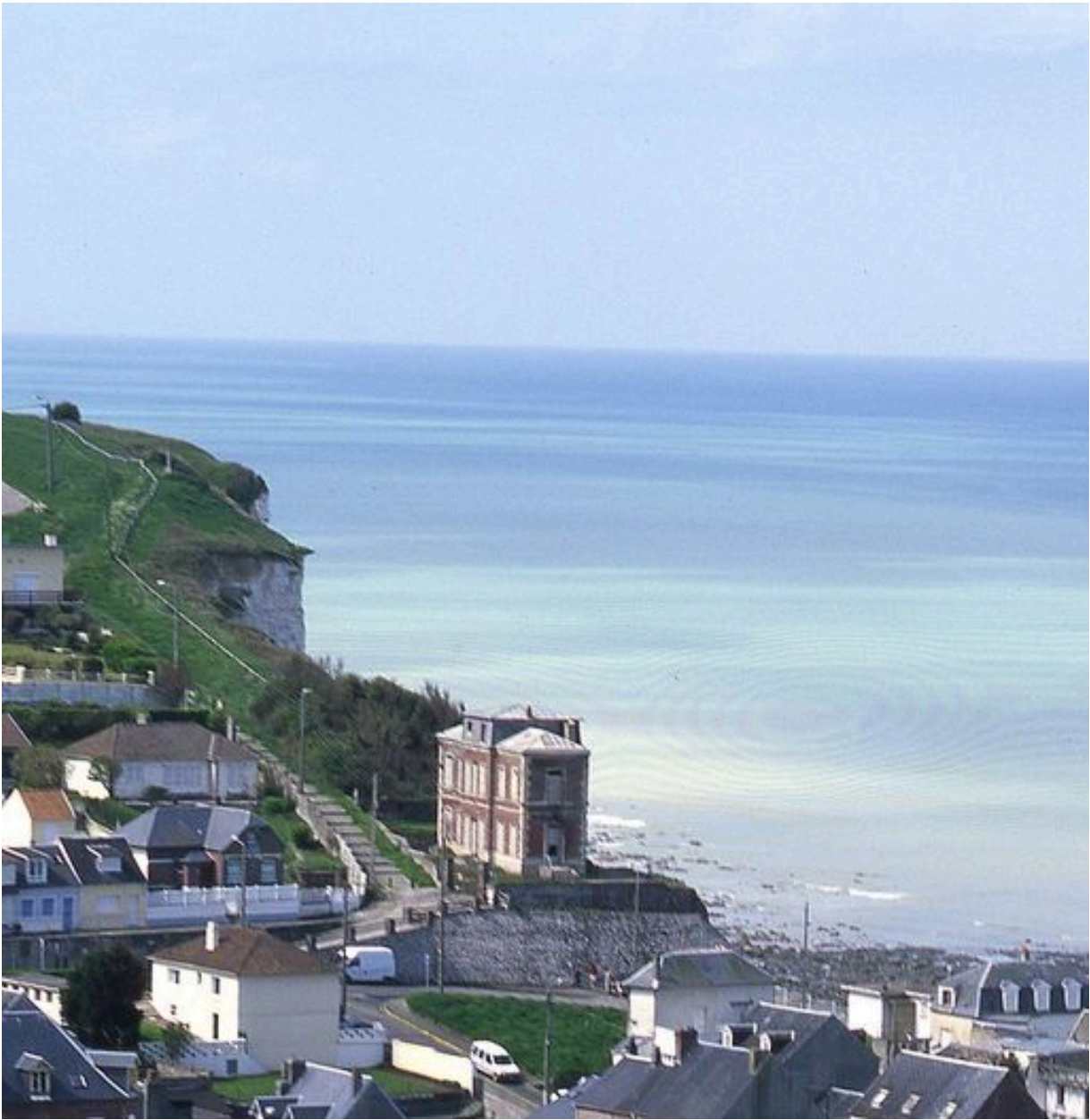
Vue d'ensemble depuis le site du Moulinet.
