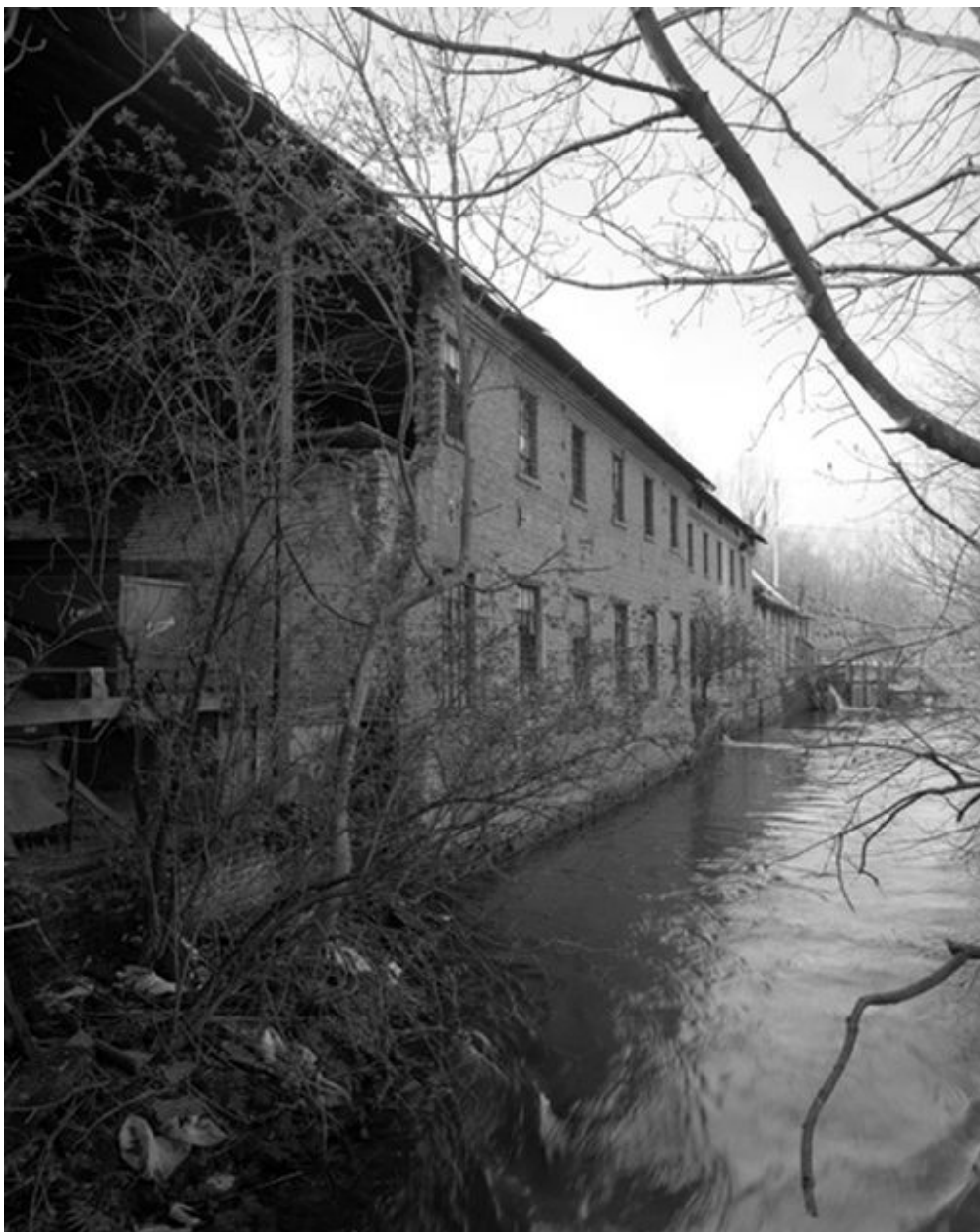
Vue de l'atelier (flanc nord).
