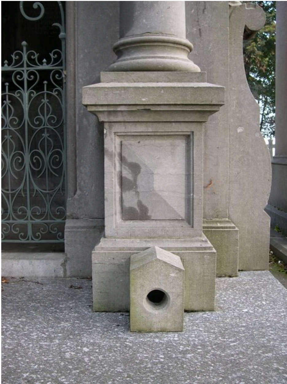
Vue de l'aération du caveau.
