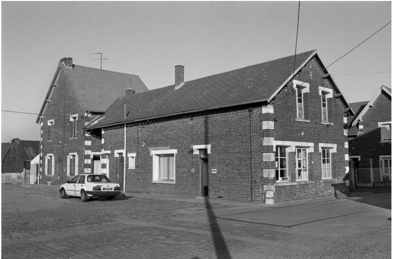
Bureau, pont bascule.
