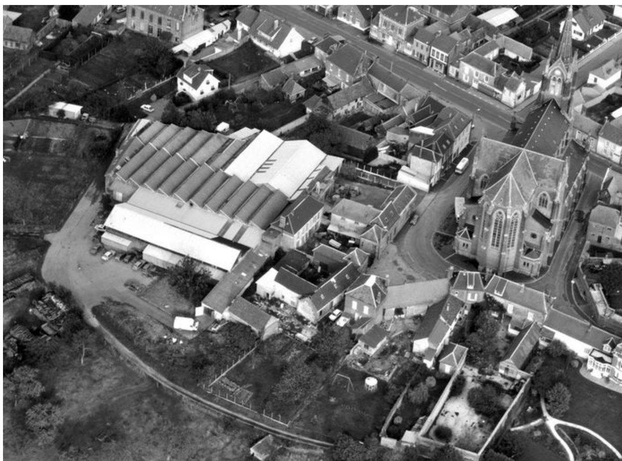
Vue aérienne, flanc ouest.
