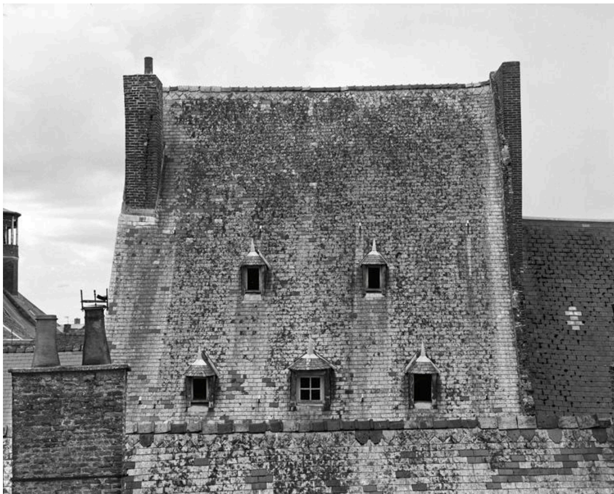
Vue du toit et des lucarnes à la capucine, depuis l'est.
