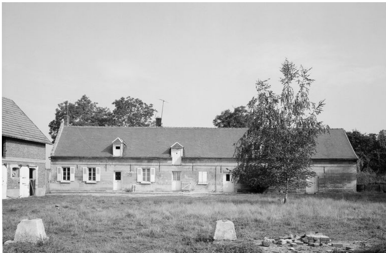
Logis. Elévation antérieure.
