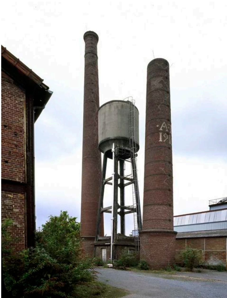
Ensemble de deux cheminées encadrant le château d'eau.
