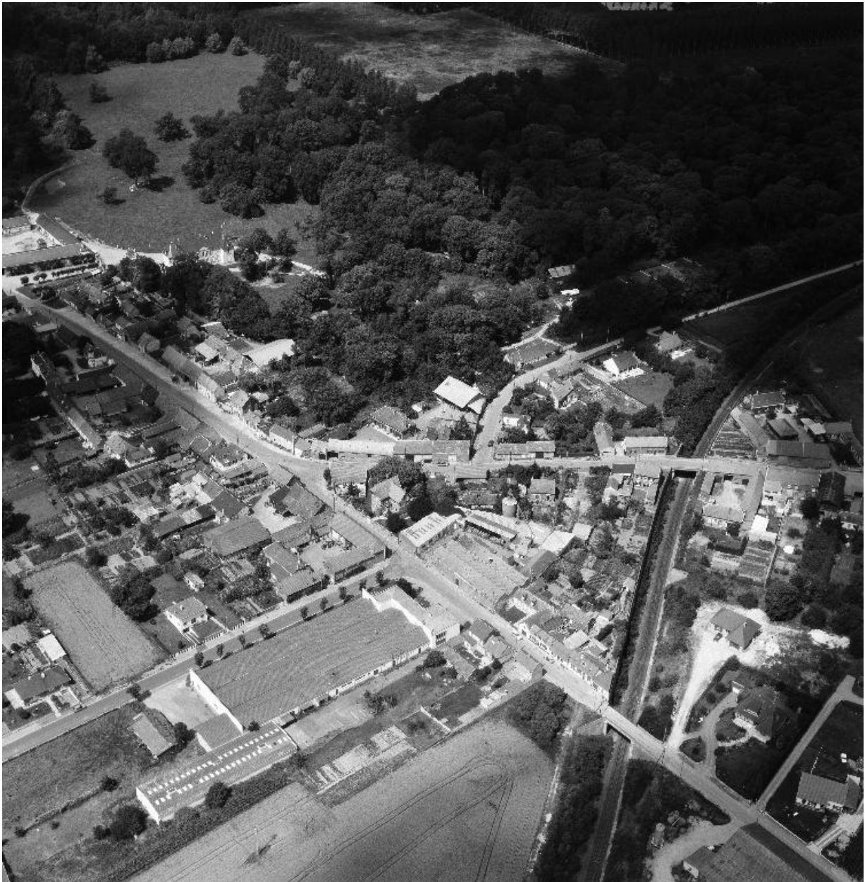
Vue aérienne, flanc sud-est.
