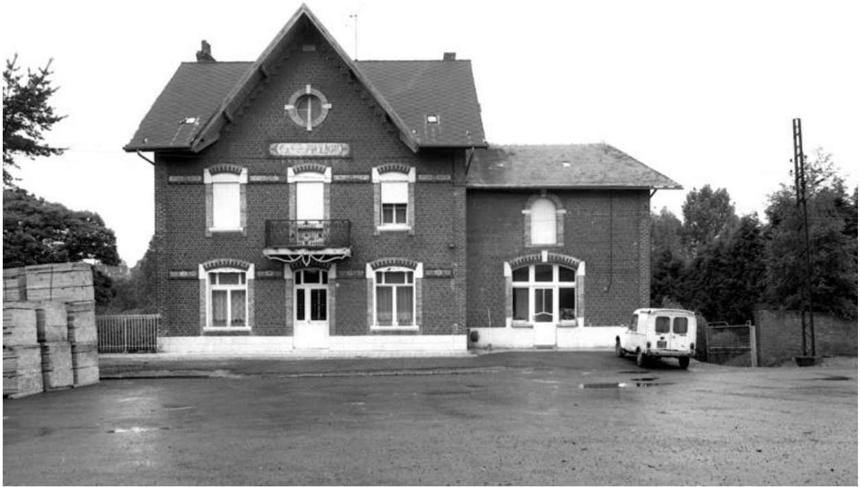
Vue d'ensemble de la façade.
